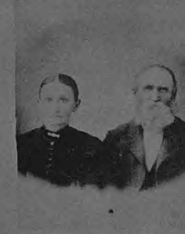
WILLIAM E. NOCKEN CRANE
